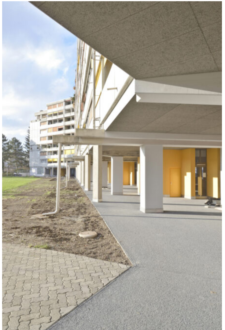
Erdgeschoss - Durchlässigkeit wiederhergestellt
