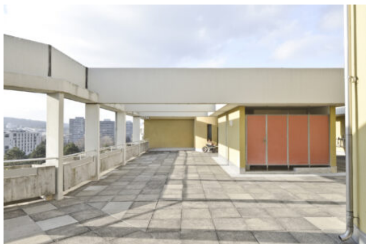
Terrasse neu isoliert und instandgesetzt
