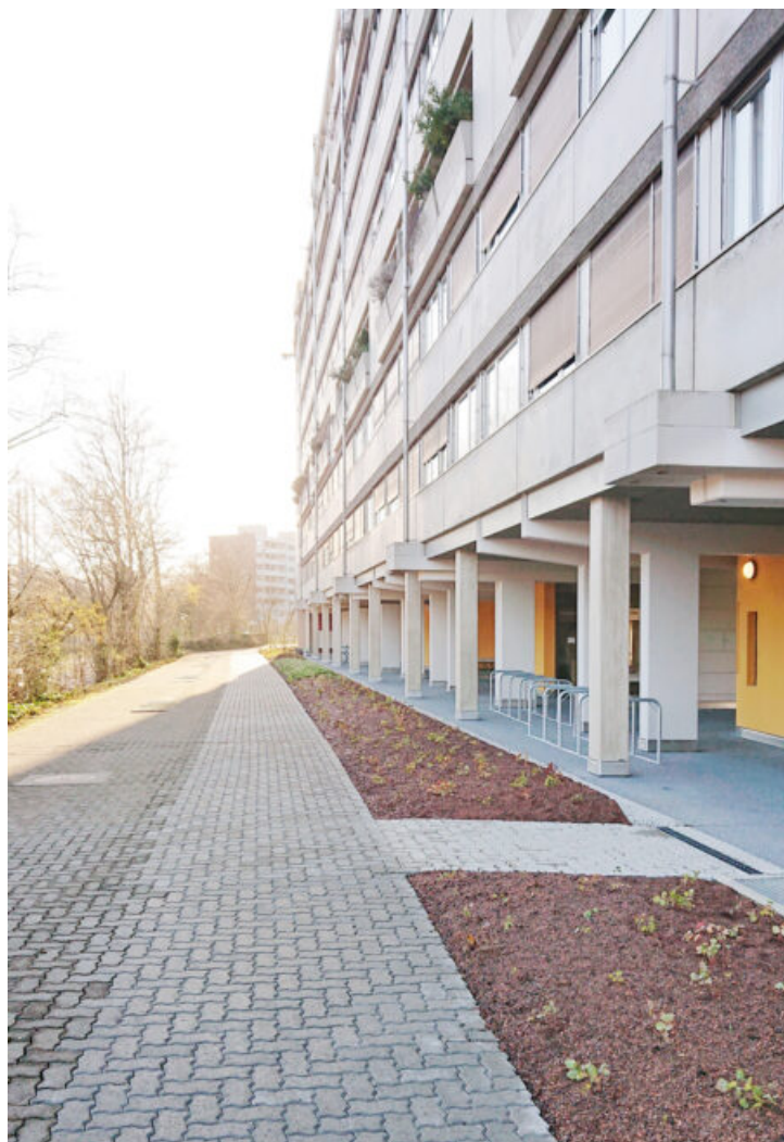
Erdgeschoss - Durchlässigkeit wiederhergestellt
