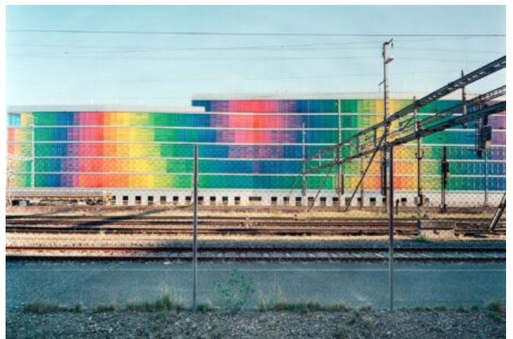
Südfassade (Storen unten)
